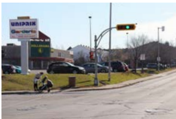
Rayon de virage large et marquage au sol minimal pour la traverse piétonne
