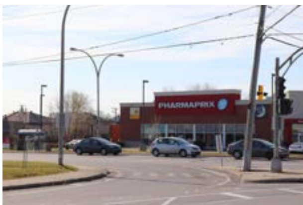
Îlot de virage à droite avec marquage au sol pour piétons et cyclistes
