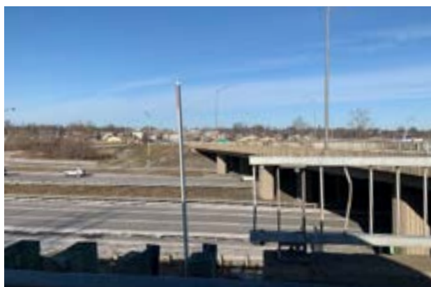
Autoroute A-440 et boulevard des Laurentides
