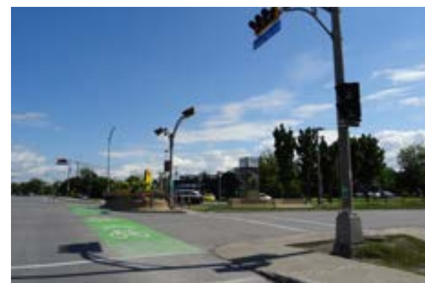
Îlot de refuge pour les piétons et marquage au sol pour les cyclistes
