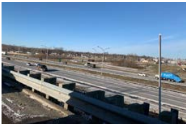
Autoroute A-440 et boulevard des Laurentides
